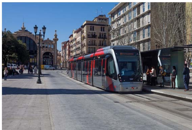
Figura 2. Parada del tranvía actualmente existente. Tramo sin catenaria
